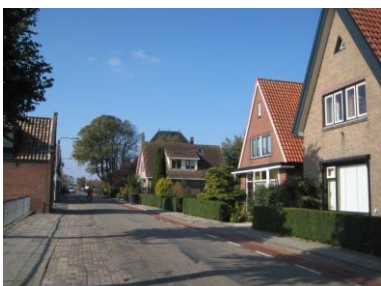
Bij verbouwing dient de zorgvuldige taillering van dit soort gebouwen te worden gerespecteerd.
