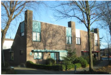
Het gebruik van signaalkleuren is niet gewenst.
