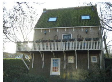
Inspelen op karakteristieke niveauverschillen.
