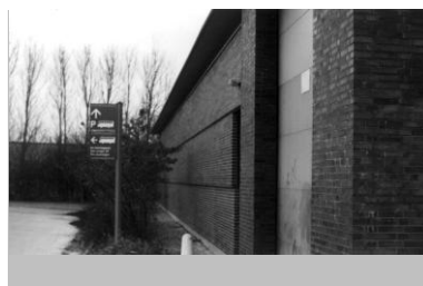
Zorgvuldige detaillering van het depotgebouw. Een gebouw dat 'onder architectuur' is gebouwd is een belangrijke aanwinst voor een industrieterrein.
