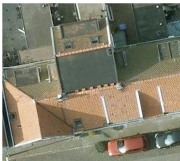
De achterzijde van een dakopbouw aan de achterkant is (afgeschuind) vormgegeven overeenkomstig het dak waar tegen aan gebouwd wordt.
