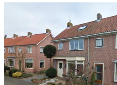
De woning in een rij is vormgegeven als deel van het geheel. Toevoegingen moeten passen in het ensemble.
