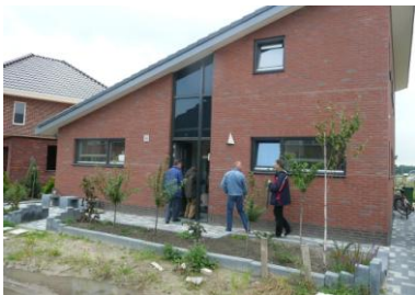
Dergelijke opvallende dakvlakken vragen om een zorgvuldige plaatsing van dakramen en dakkapellen.
