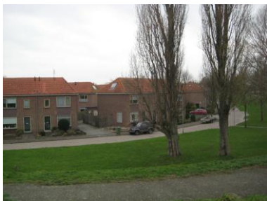
Asterstraat: verfijnd metselwerk en detaillering.
