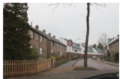
Ingrijpende renovatie in laatste deel Tom Kranenburgstraat: aansluiting bij wederopbouwarchitectuur beperkt.
