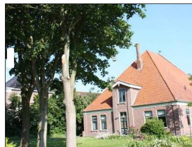
Stolp met pannendak.
