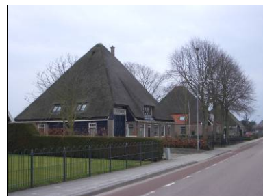
Stolp met dakvenster aan voorzijde en laaggeplaatste dakramen.
