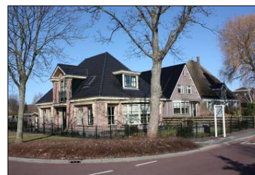
Nieuwbouw gebaseerd op traditionele gebiedseigen bouwvorm.
