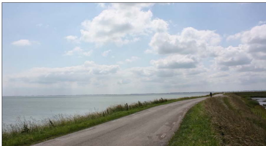
De Westfriese Omringdijk is één van de provinciale monumenten
