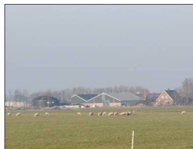
Mestvergistingsinstallatie op het achtererf.
