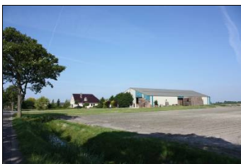
Onvoldoende landschappelijke inpassing bedrijfsbebouwing.
