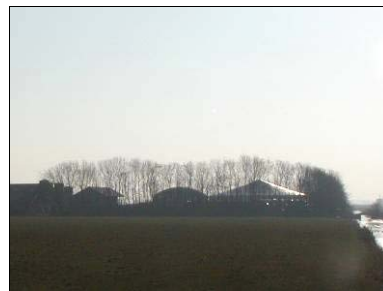
Mestvergistingsinstallatie plaatsen binnen erfbeplanting.
